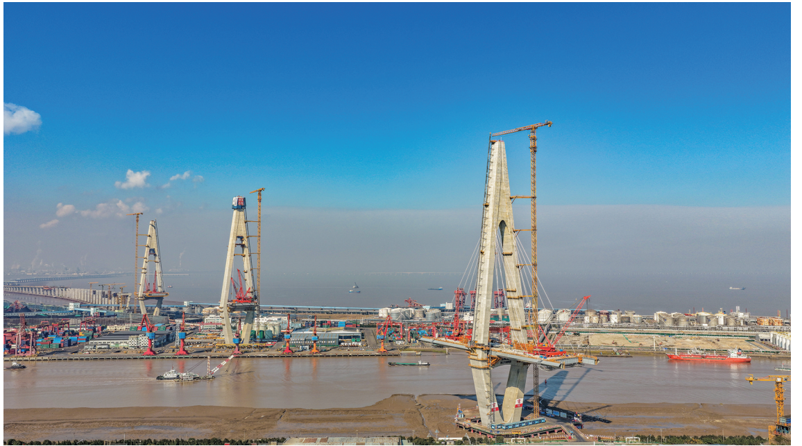
杭甬高速复线宁波段三期项目建设现场。余明霞/供图
