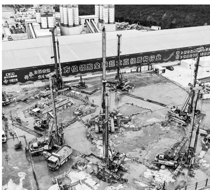
施工现场。姚峰/供图
