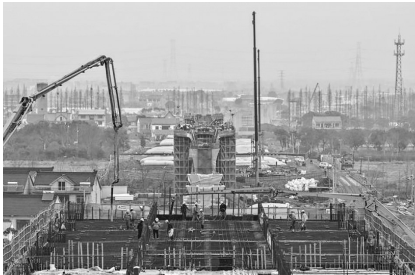
混凝土浇筑现场。徐云霞/供图
