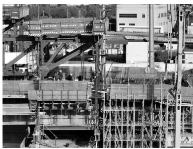
施工现场。孟丽萍/供图
