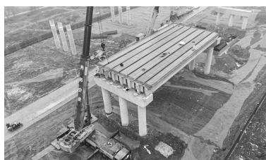
梁板架设现场。金佳卉/供图
