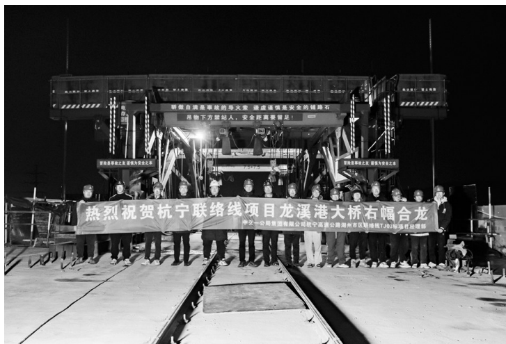
大桥合龙现场。孟丽萍/供图
