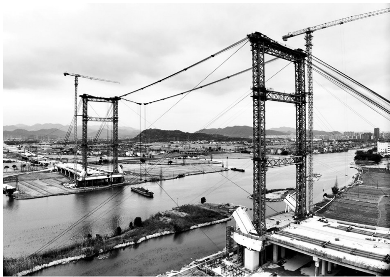
缆索吊装系统荷载试验现场。朱娅娅/供图
