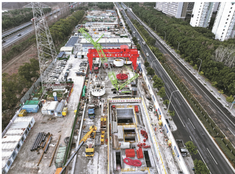
世纪大道南延综合管廊工程施工现场。张维/摄
