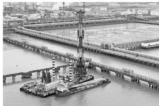
施工现场。宁波北仑海事处供图
