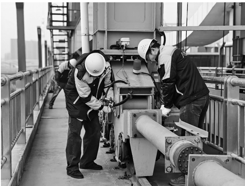
八堡船闸技术人员检修船闸设备。谢颖/摄
