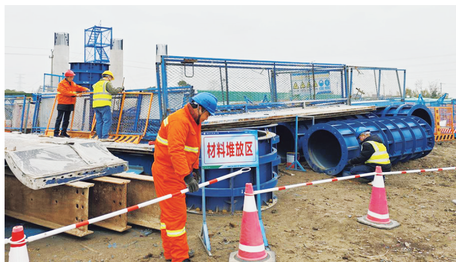
施工现场。王阳/供图
