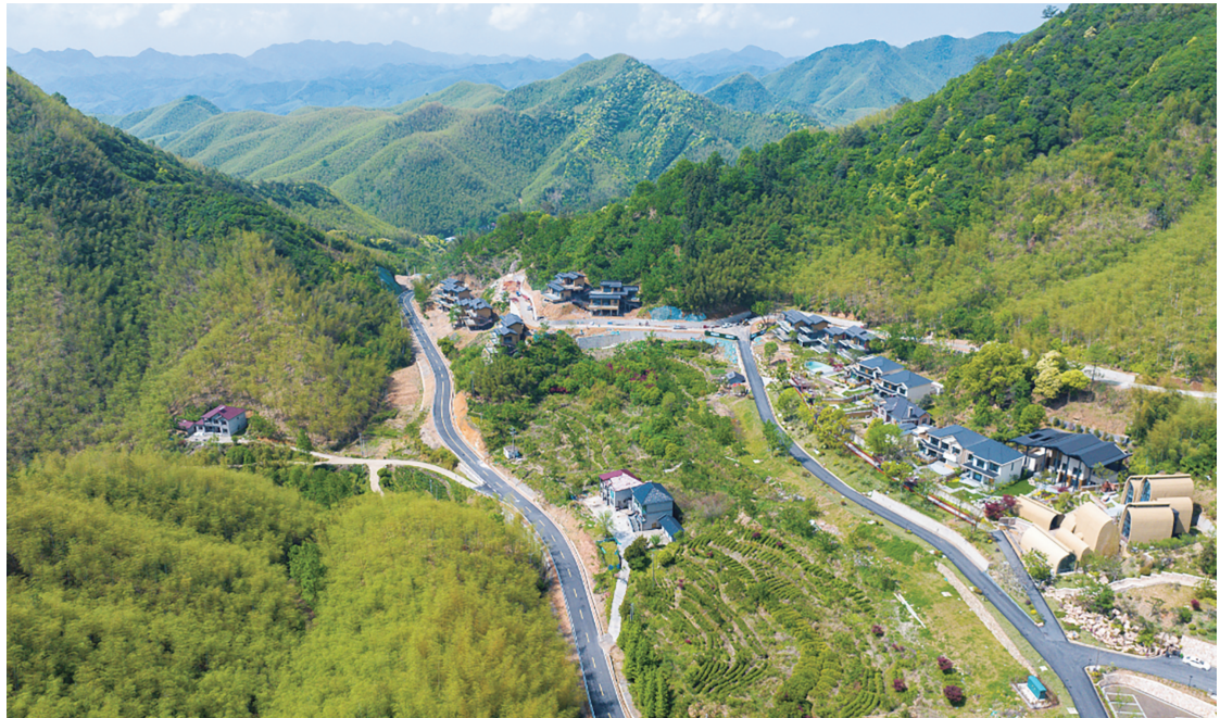
安吉文七线俯瞰图。湖州市公路与运输管理中心/供图
