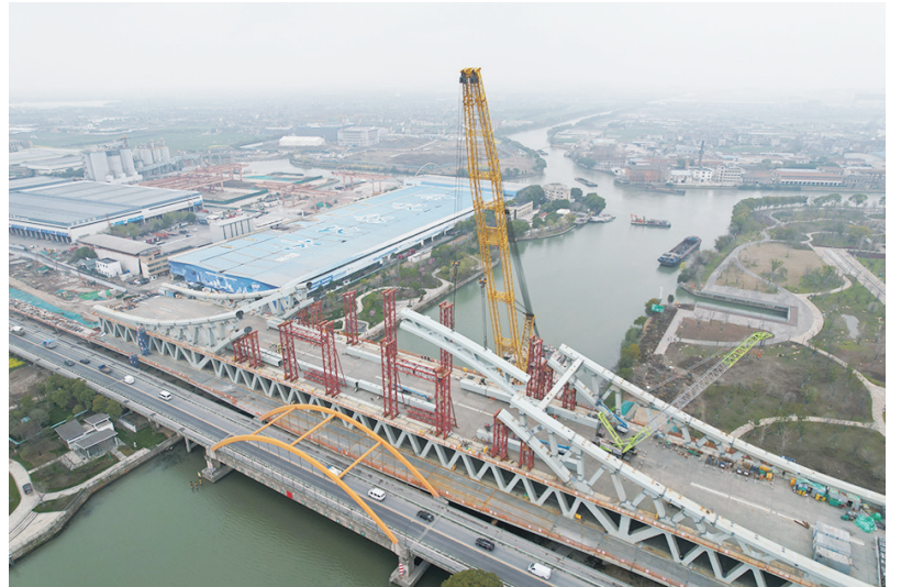
吊装现场。金佳卉/供图
