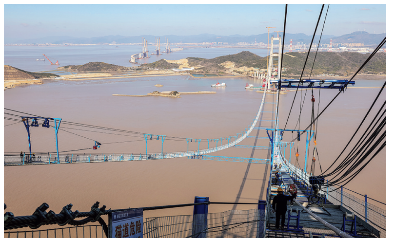
主缆架设现场。姚峰/供图
