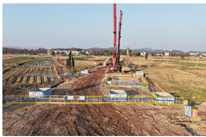
麻阳港大桥施工现场。韦凯锋/供图
