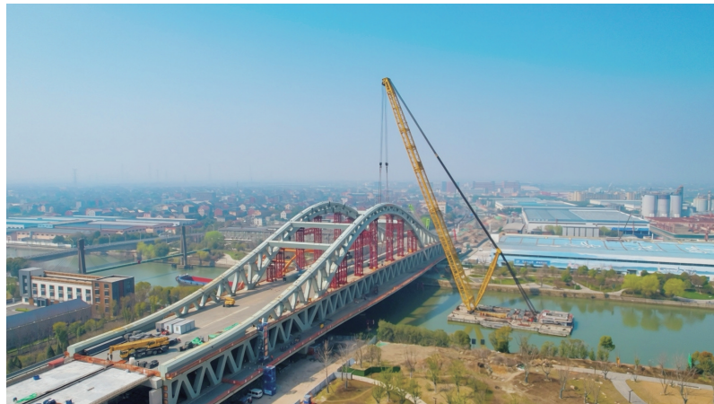
运河大桥项目建设现场。计丽艳/供图
