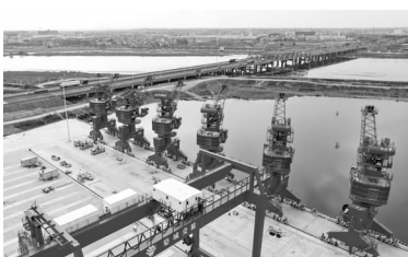
金华港婺城港区乾西作业区项目建设现场。钟路/供图
