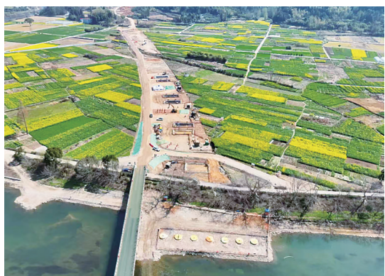
姚家村大桥施工现场。 湛宗荣/供图
