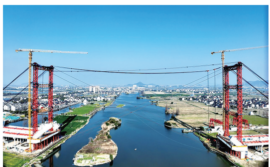
钢拱肋吊装现场。 孔艳冬/供图
