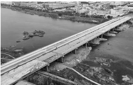
上三高速增设天台东互通工程项目办/供图
