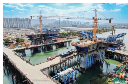
TJ02标桥梁施工现场。毛琼莺/供图
