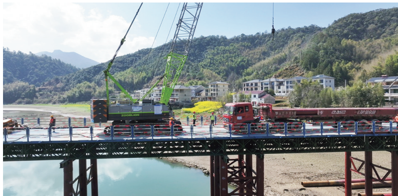
项目建设现场。常星昊/供图
