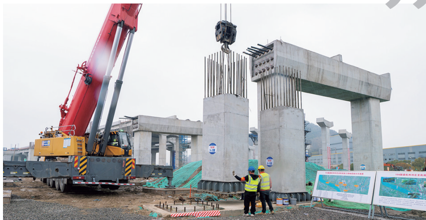
104国道萧山段建设现场。 周鹏/摄
