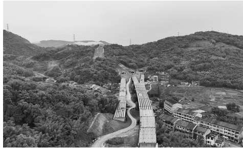
施工现场。苍泰高速4标项目部/供图
