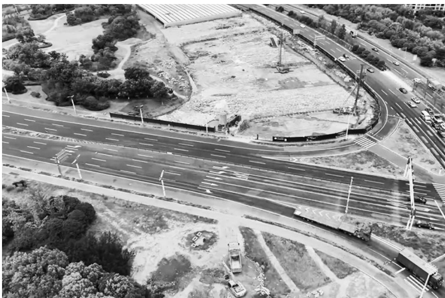
无人机视角下的嘉兴在建工程。黄颜艳/摄
