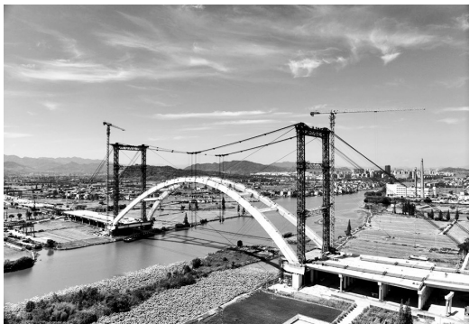
萧曹运河拱桥建设现场。朱娅娅/供图
