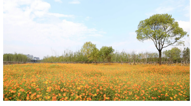
11月7日,记者在兰溪市扬子江海绵城市生态整治工程现场看到,园圈内花开满园,黄色的花朵在枝头绽放,美不胜收。据悉,该工程计划于今年年底完工。 记者 赵红霞 通讯员 陈欢文/摄
