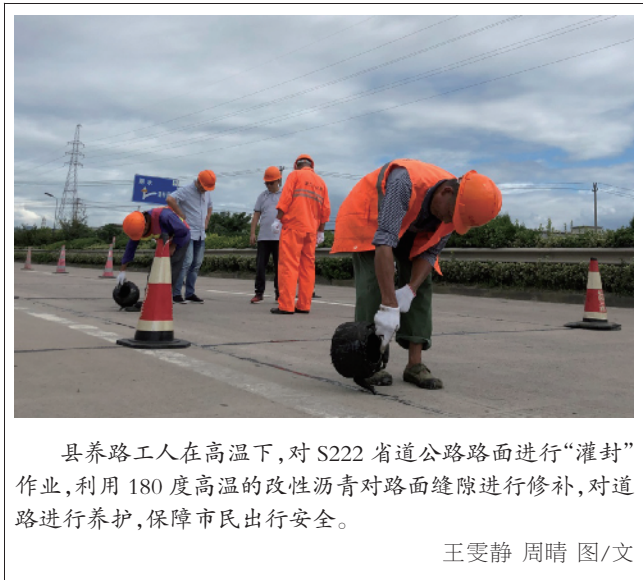
县养路工人在高温下，对S222省道公路路面进行“灌封”作业，利用180度高温的改性沥青对路面缝隙进行修补，对道路进行养护，保障市民出行安全。
