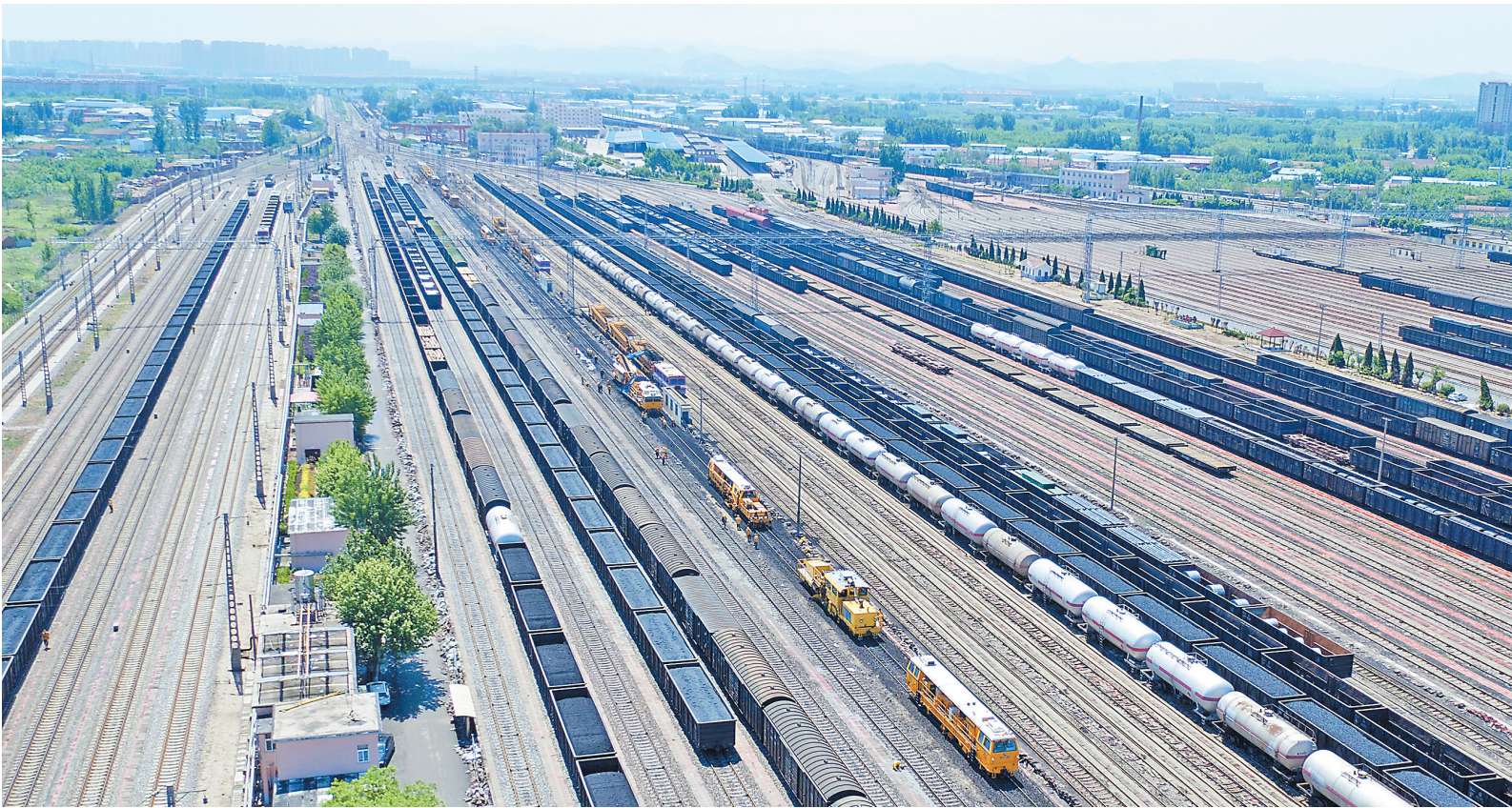
5月11日拍摄的济西站股道改造施工现场(无人机照片)。连日来，作为中欧班列以及京沪铁路、胶济铁路沿线的重要铁路枢纽，中国铁路济南局集团有限公司济西站进行股道改造施工。该工程将老式轨枕和钢轨全部拆除，更换成混凝土轨枕和最新型钢轨。工程完工后平均每列车编组效率将提高0.5小时，有效提升中欧班列以及京沪铁路、胶济铁路的运输能力。
