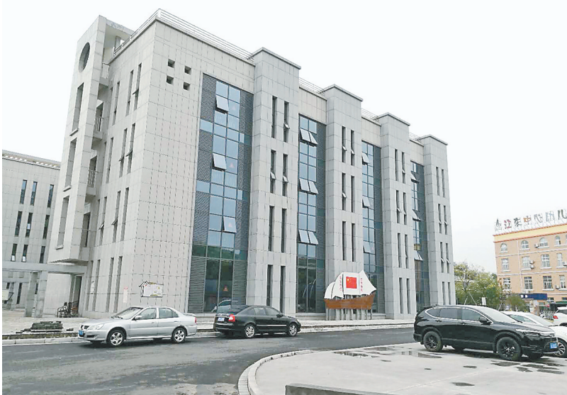
下傅村“一村两楼宇”项目
