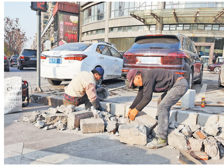
施工人员忙着更换破损路砌石。
