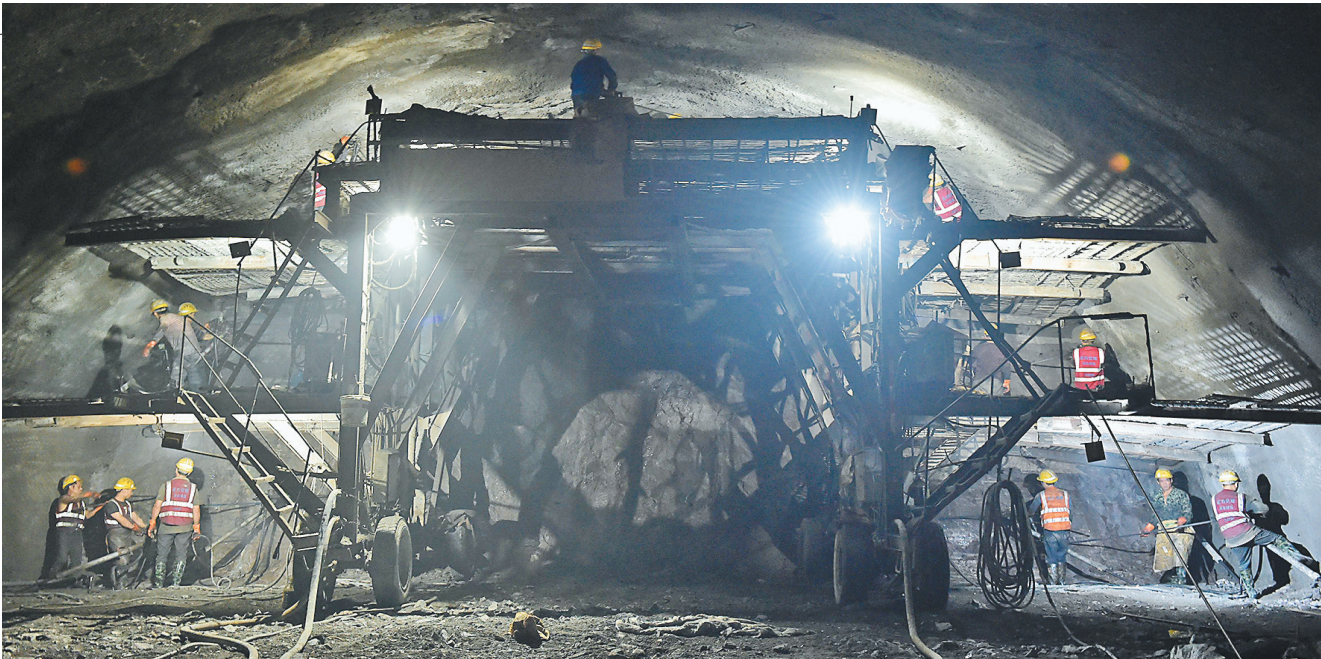
施工人员加紧挖掘隧道。
