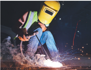
对二衬钢筋进行焊接作业。
