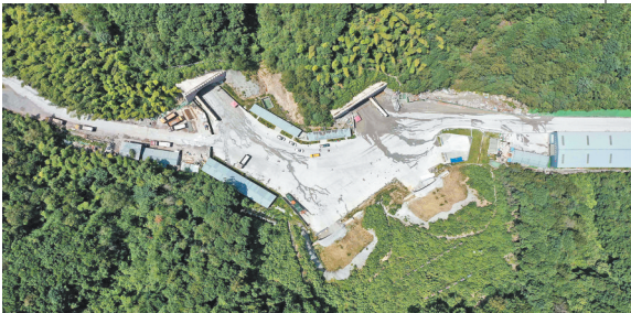
俯瞰施工中的枫坑隧道。
