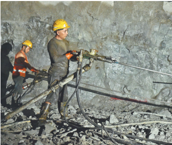
在隧道内进行钻孔作业。
