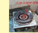
无熄火保护装置的燃气灶
