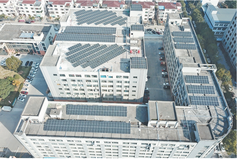
“春华微谷”小微园分布式光伏发电。
