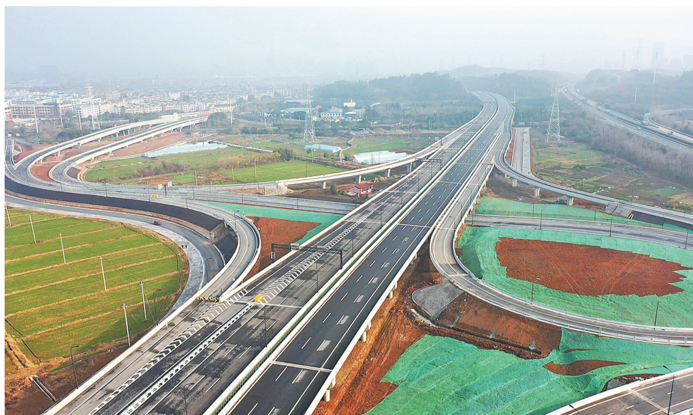
气势恢宏的义乌江东连接线工程。
