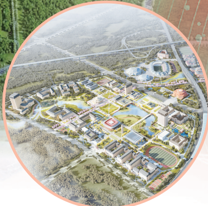
浙大国际医学院及基础配套服务设施工程(一期)
