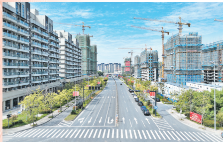
苏溪镇“六纵十横”交通路网体系之镇前街延伸。
