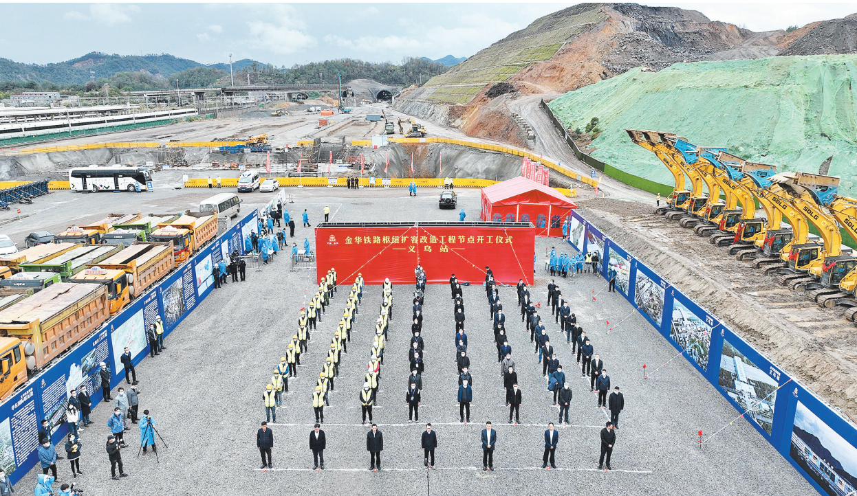
昨日，金华铁路枢纽扩容改造工程节点开工仪式义乌分会场现场。 全媒体记者 吕斌 摄
