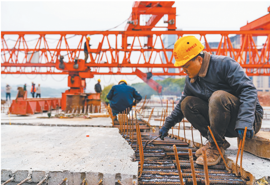
施工人员在绑扎钢筋。
