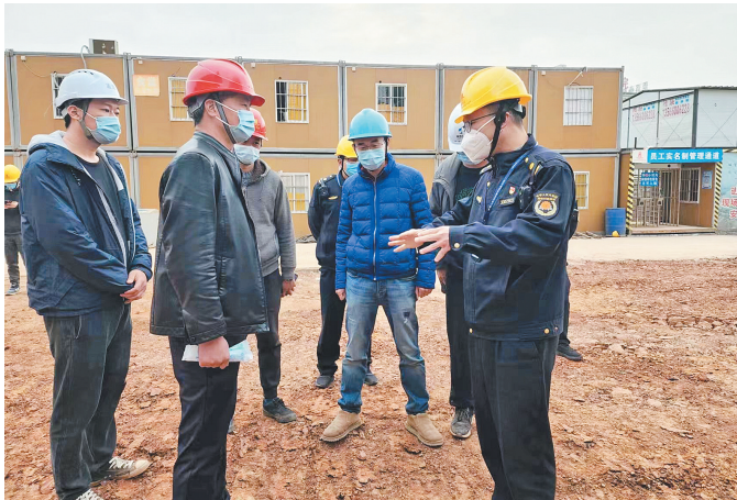
检查人员提醒工地负责人要重视安全。
