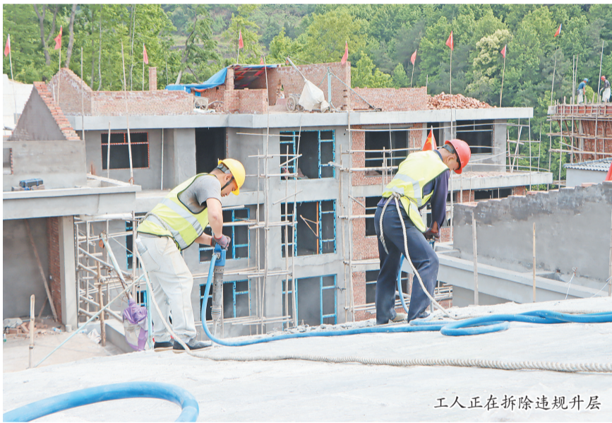
工人正在拆除违规升层
