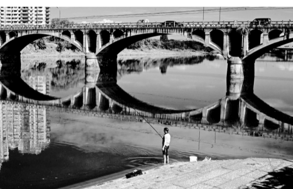
伏虎桥(佛堂大桥)。
