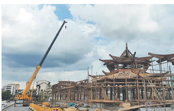
建设中的伏虎桥。
