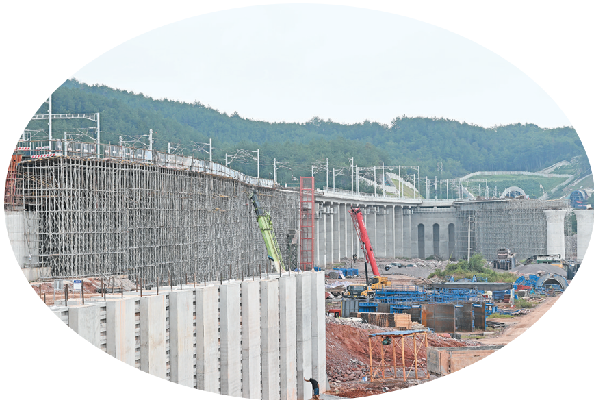
施工现场。 全媒体记者 孙航宇 摄
