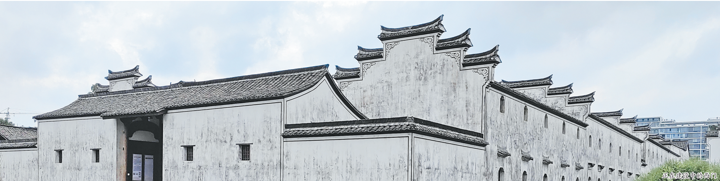
正在建设中的西门
