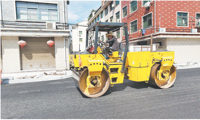
施工人员在平整道路。
