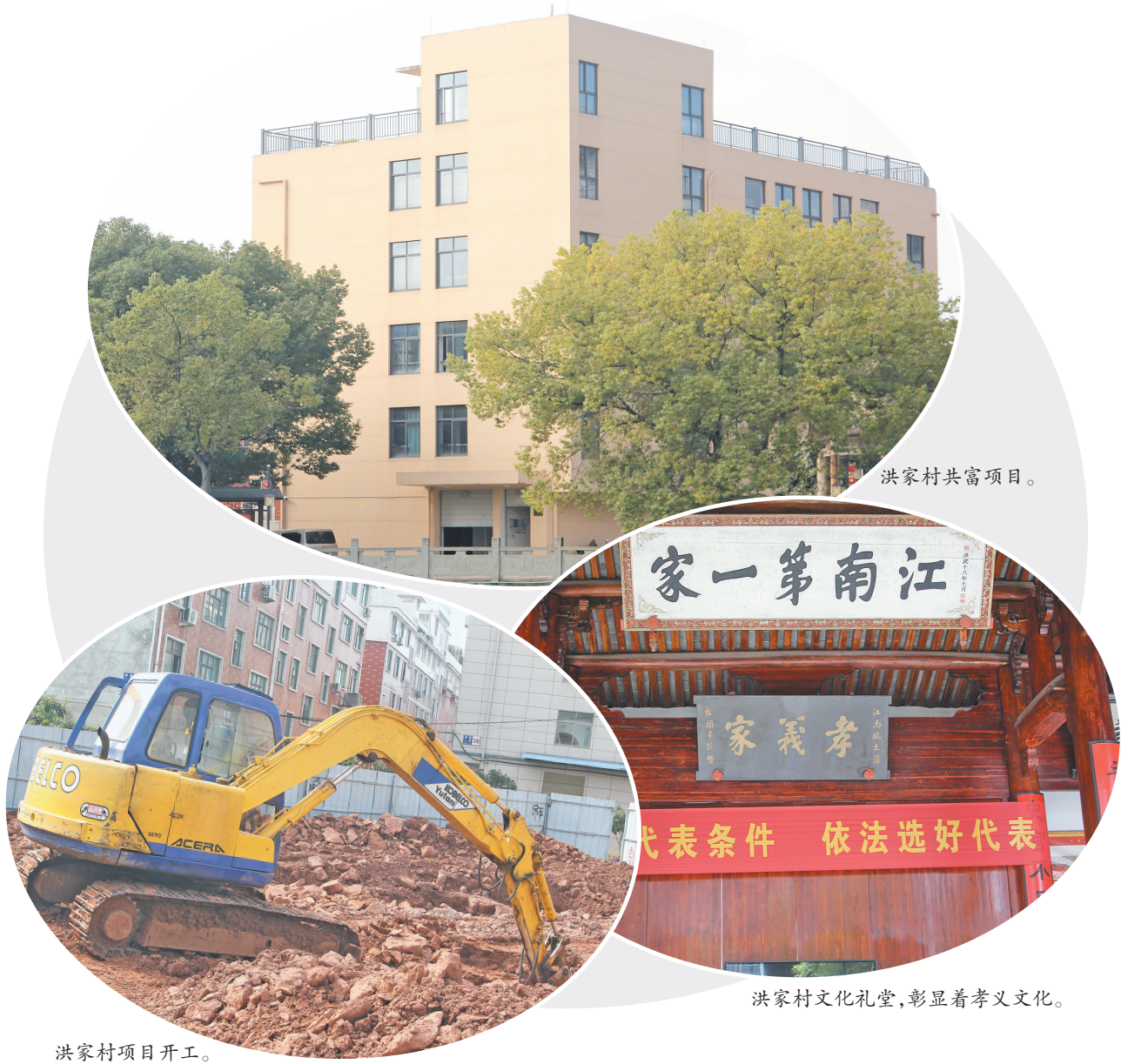
洪家村项目开工。
